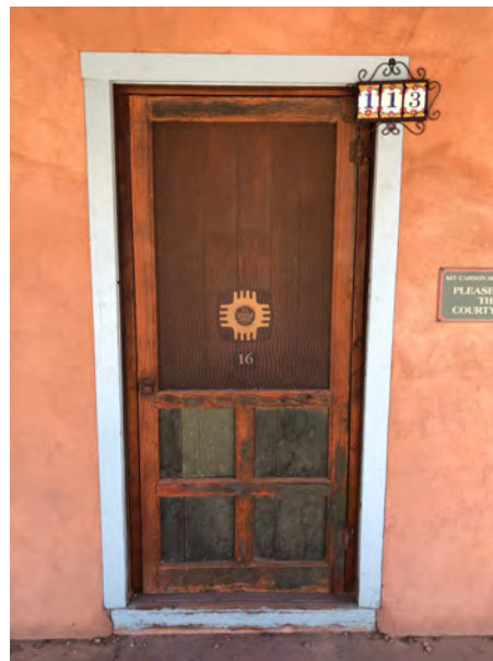
DOOR A - EXTERIOR
